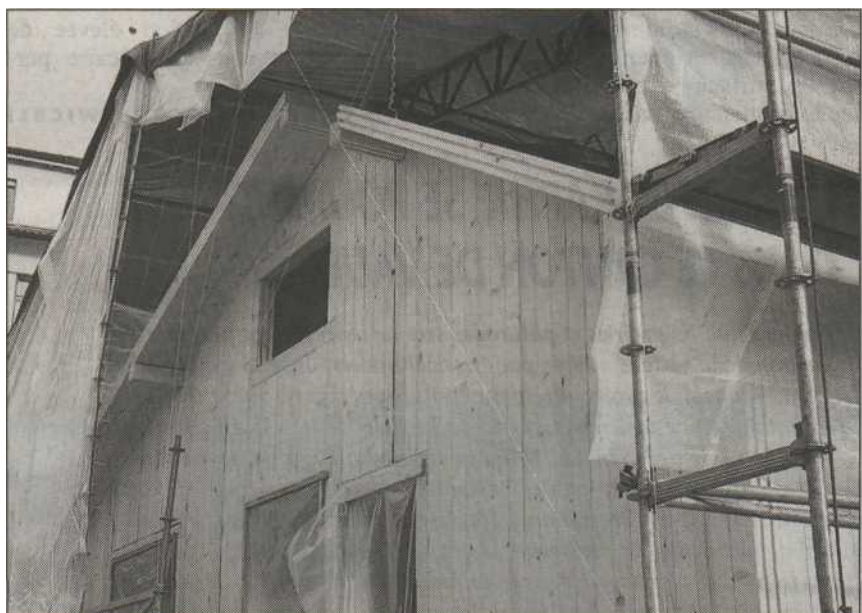
LA MAISON est sous toit.
