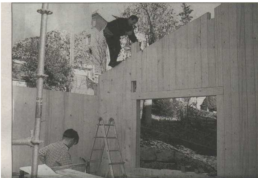
LE MONTAGE des murs extérieurs.
