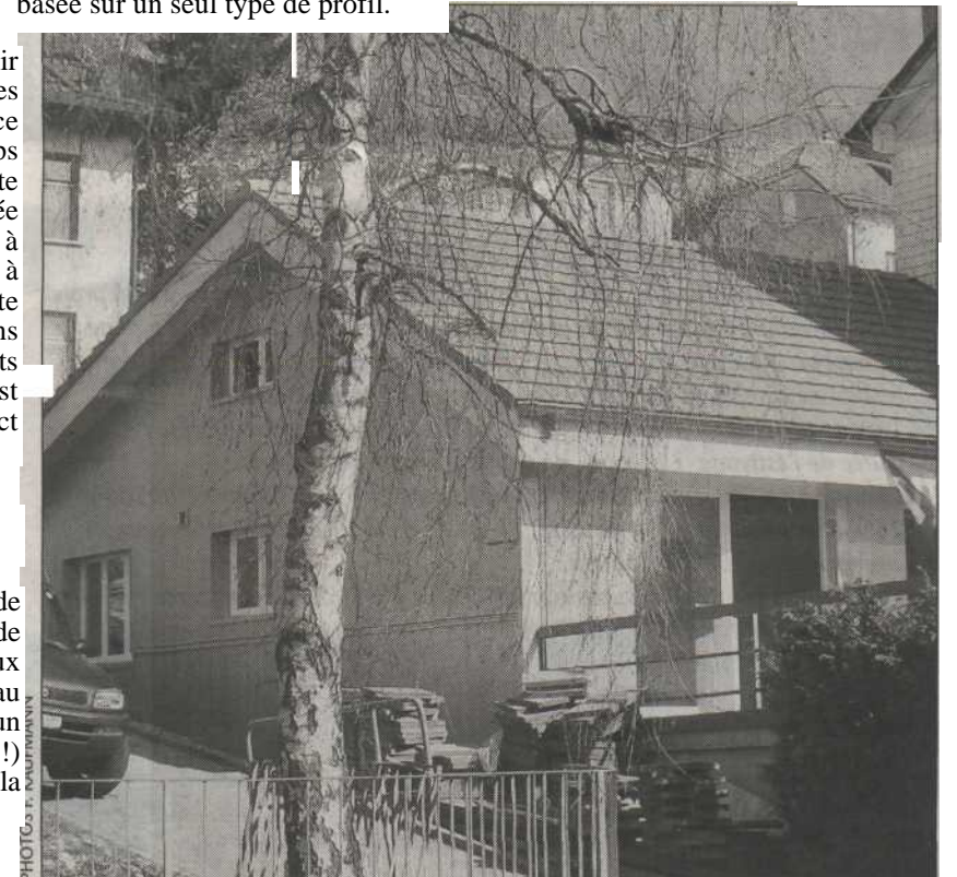
EN AVRIL 2005, la maison est terminée.
