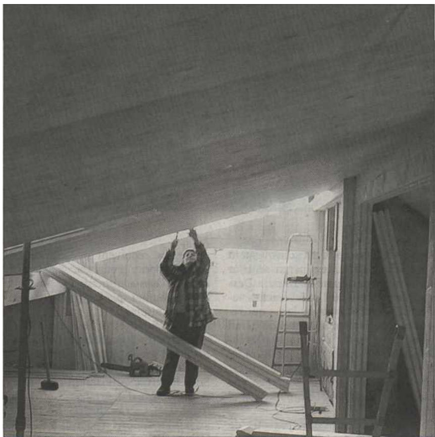
LA POSE des éléments de toiture.
